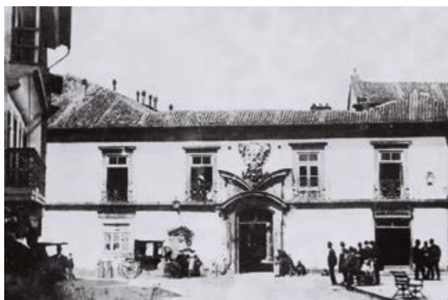
Hospital da Santa Casa da Misericórdia no Largo da Matriz
