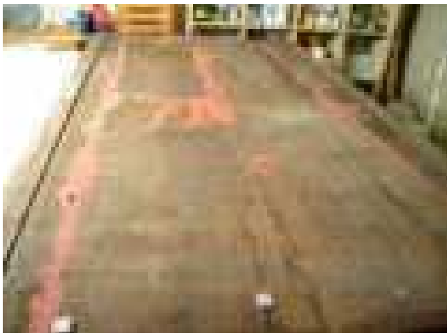
Figura 1 - Preenchimentos inadequados do suporte pelo tardo, áreas carcomidas, apodrecidas pelo insecto xilófago
