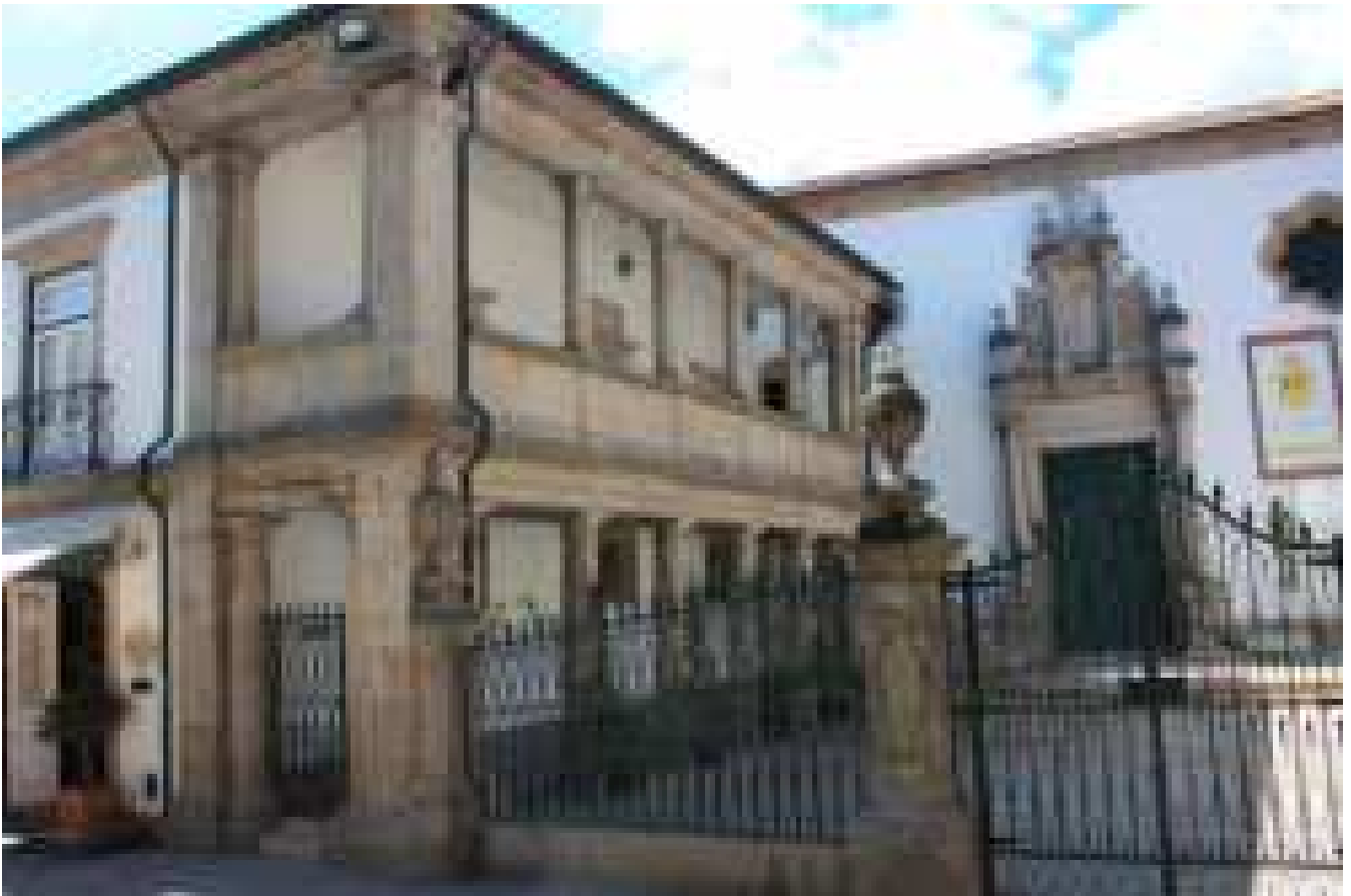
Varanda colunada da Misericórdia, outrora acesso às enfermarias do Hospital
