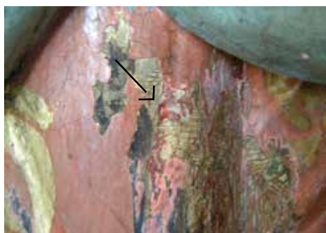
Figura 15- Testes- abertura de janelas de observação para verificar a existência de policromia original
