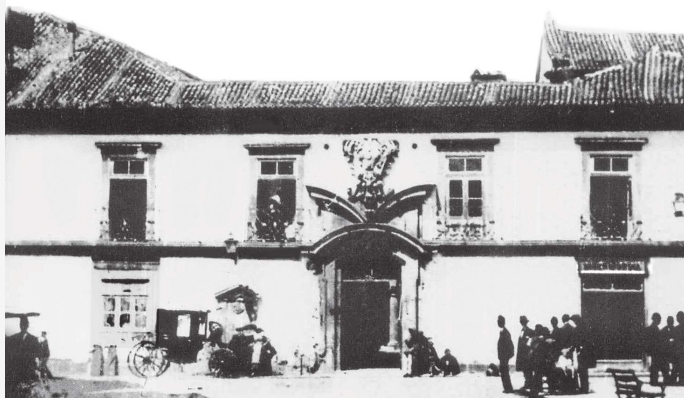
Hospital da Praça
